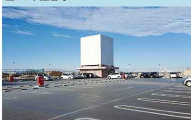
2018年撮影 【構造】RC造 【工法】ポリルーフCPS-1工法(FRP防水単体密着仕様) 【施工】1992年7月【面積】2,000㎡
