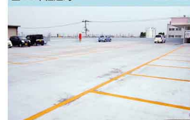
2012年撮影 【構造】S造 【工法】ポリルーフPP-1工法 【施工】1997年3月【面積】1,400㎡
