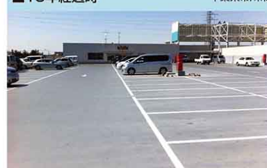
2012年撮影 【構造】S造 【工法】ポリルーフPP-1工法 【施工】1997年4月【面積】4,600㎡
