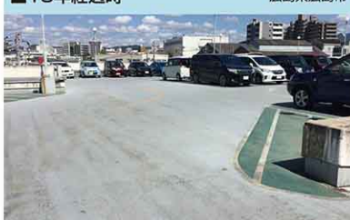
2018年撮影 【構造】RC造 【工法】ポリルーフPP-1V工法 【施工】2000年9月【面積】6,600㎡
