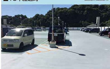
2018年撮影 【構造】RC造 【工法】ポリルーフPP-1V工法 【施工】2000年10月【面積】7,300㎡
