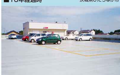
2012年撮影 【構造】S造 【工法】ポリルーフPP-1工法 【施工】1996年11月【面積】1,300㎡
