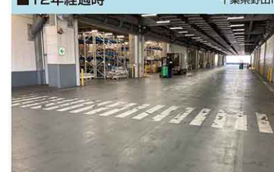
2021年撮影 【構造】S造 【工法】ポリルーフPP-2VS工法 【施工】2009年8月【面積】17,700㎡
