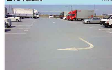
2018年撮影 【構造】S造 【工法】ポリルーフPP-1V、2V工法 【施工】2003年6月【面積】9,000㎡
