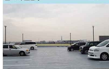
2019年撮影 【構造】S造 【工法】ポリルーフPP-1V工法 【施工】2002年12月【面積】4,200㎡
