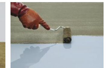
▶ ③FRP用プライマー ●[ポリルーフS-1R/セメント] 0.2kg/m 2 を標準に塗りむらのない様に均一に塗布する。 (一液タイプ)
