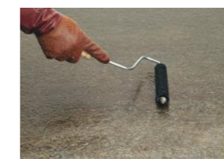
▶ (脱泡処理) ●脱泡専用ローラーにて、脱泡する。
