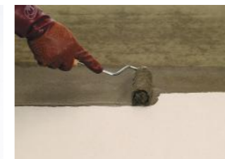
▶ ①ウレタンプライマー ●[ポリルーフS-1/セメント] 0.3kg/m 2 を標準に塗りむらのない様に均一に塗布する。 (一液タイプ)
