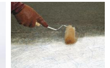
▶ ⑤下塗り ●連続して[S-2β] 1.6kg/m 2 を標準に塗布する。 (SC硬化剤1~2%混合) (二液タイプ)
