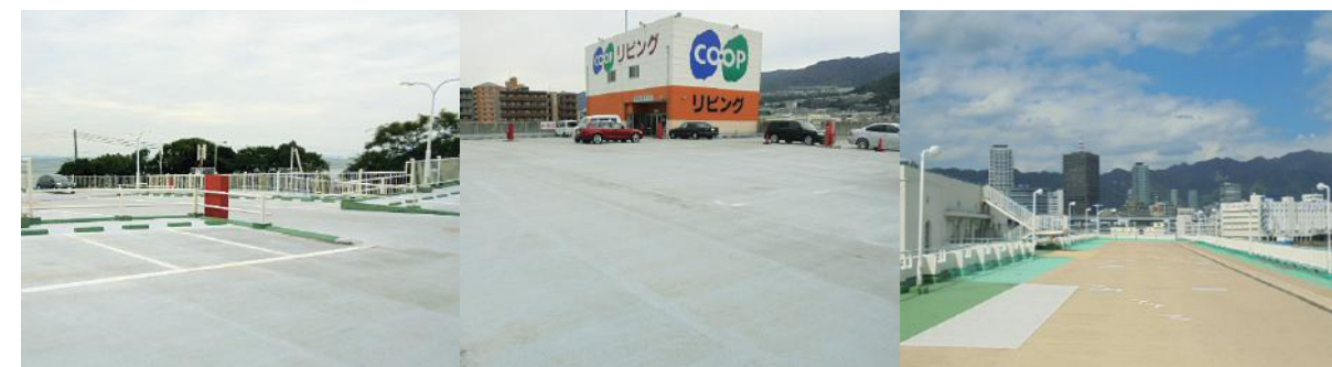
2015年撮影 19年経過 神戸市内 立体駐車場 1996年施工2,600㎡
