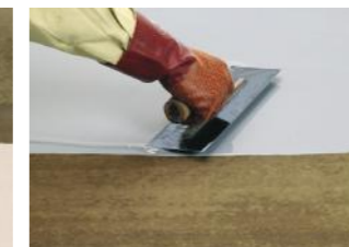
▶ ②ウレタン防水材 ●[ポリルーフPU-2] 1.5kg/m 2 をコテむらのない様に均一に塗布する。 (二液タイプ)
