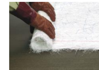
▶ ④ガラス基材 ●[ポリルーフマット#450MM-F]を全面に貼る。
