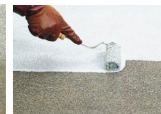
▶ ⑦中塗り ●[S-2β]硬化後、[ポリルーフS-3N(SCTナー、S-3N用添加剤混合)]0.4kg/m 2 を標準に均一に塗布する。 (SC硬化剤1~2%混合) (二液タイプ)
