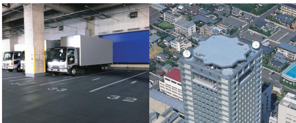
トラックヤード
