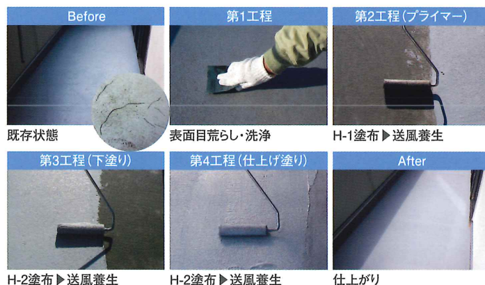
既存状態 表面目荒らし・洗浄 H-1塗布▶送風養生 H-2塗布▶送風養生 H-2塗布▶送風養生 仕上がり
