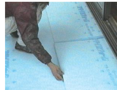
1 勾配断熱材敷き込み
