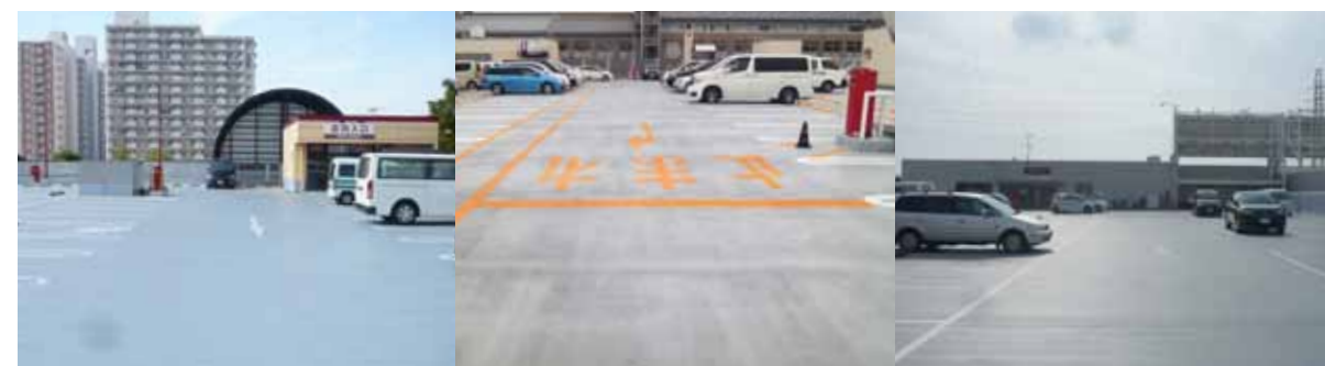
2015年撮影 12年経過 東京都江戸川区内 屋上駐車場 2003年施工3,600㎡
